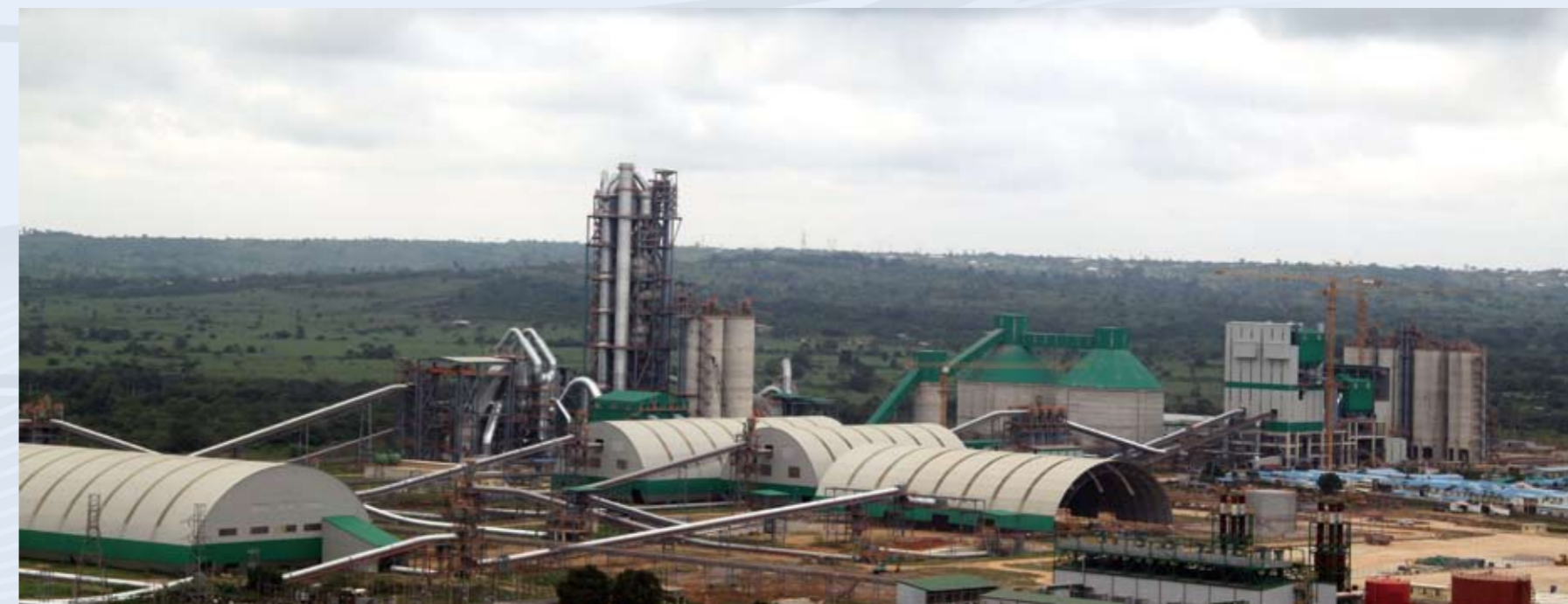
尼日利亚EWEKORO总承包项目 ( 5000 t/d ) EWEKORO EPC Project in Nigeria (5000 t/d)
